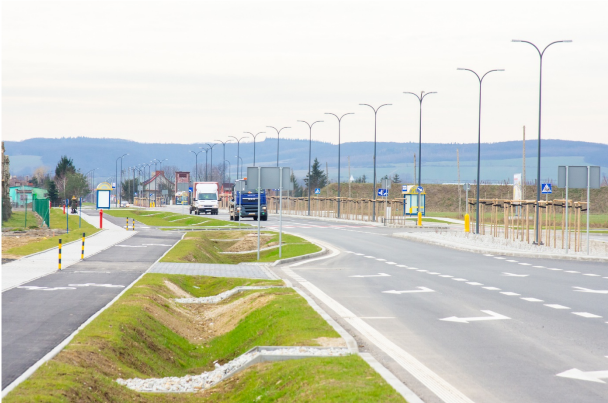
Prace budowlane przy rurociągach tłocznych i kanalizacji grawitacyjnej oraz wodociągach oraz stan po wykonaniu inwestycji
