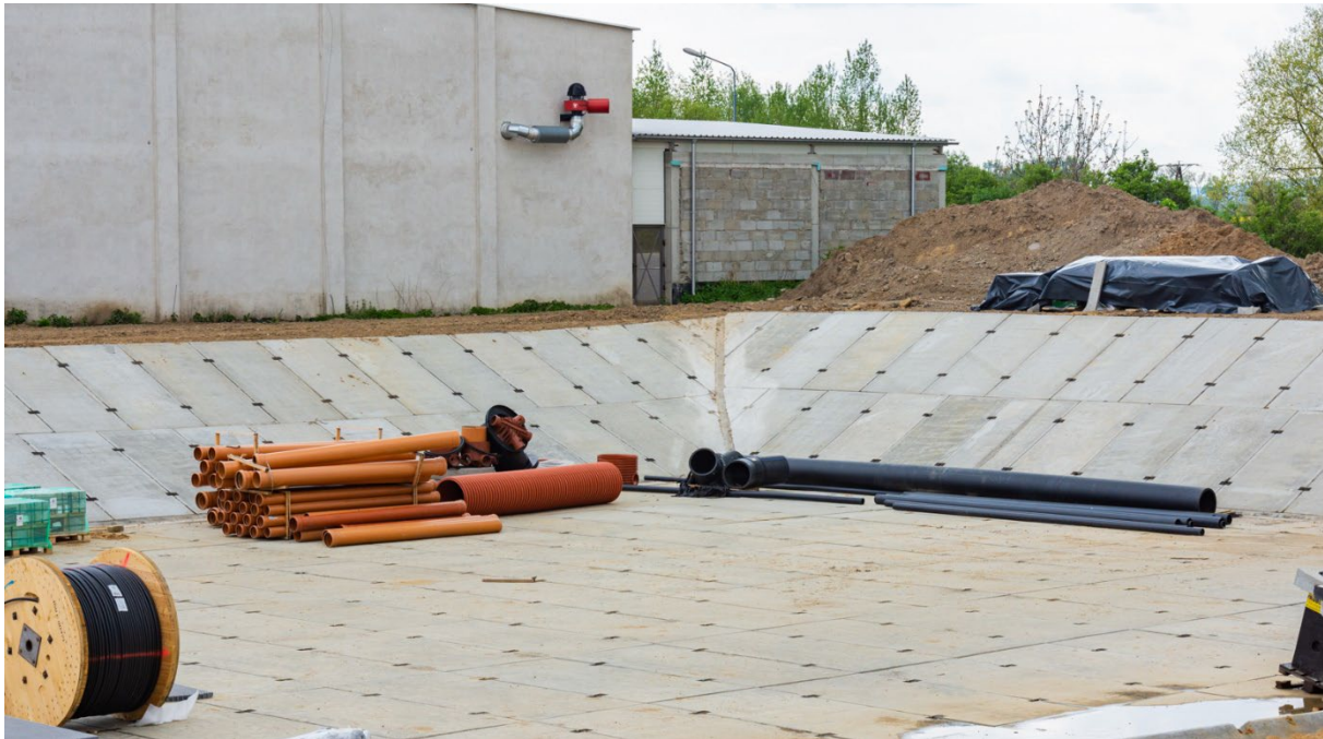
Przepompownia przed i w trakcie budowy
