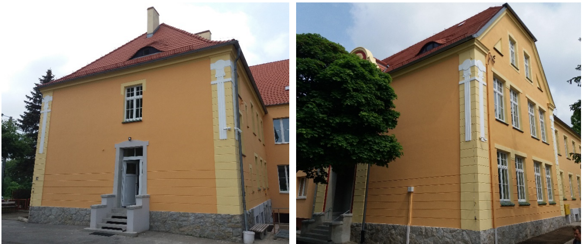
SP 4 po remoncie
