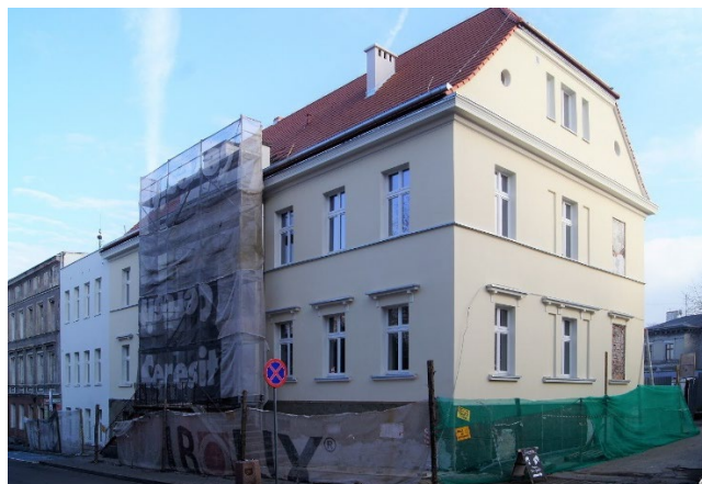
Budynek MOPS, w trakcie remontu
