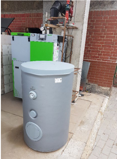
Wymiana na piec opalany biomasa
