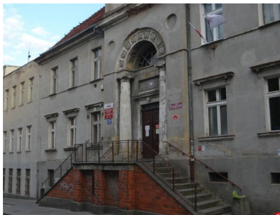
Budynek MOPS, przed remontem
