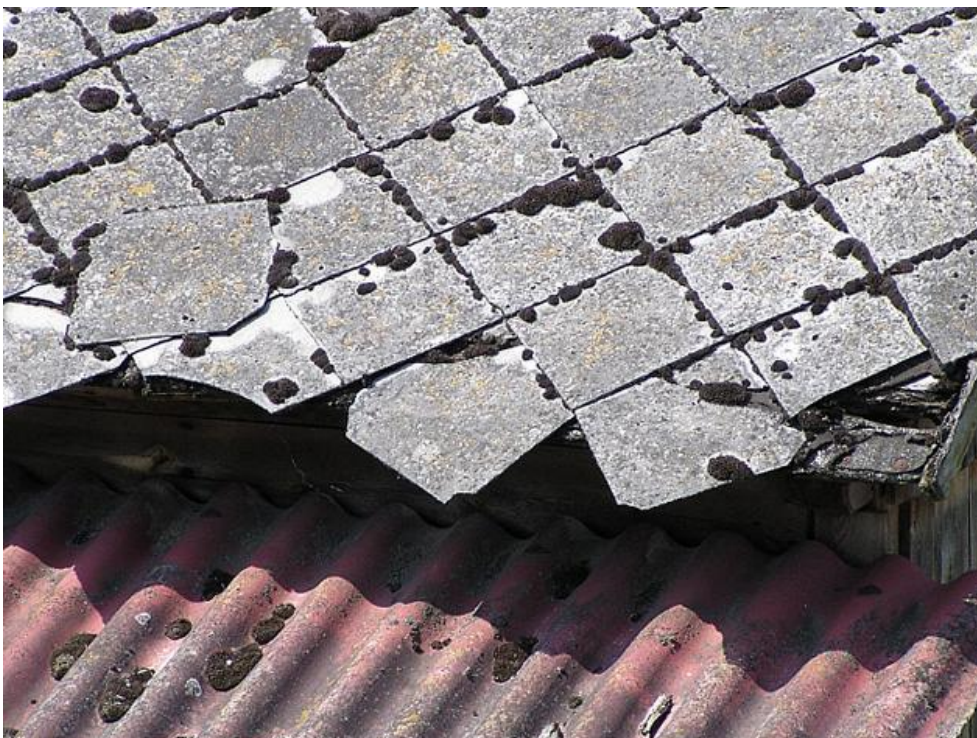
Rysunek 8 Pokrycie dachowe ocenione w I stopniu pilności
