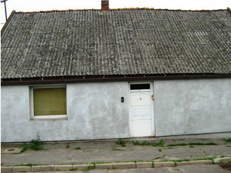
Rysunek 7 Pokrycie dachowe ocenione w II stopniu pilności.
