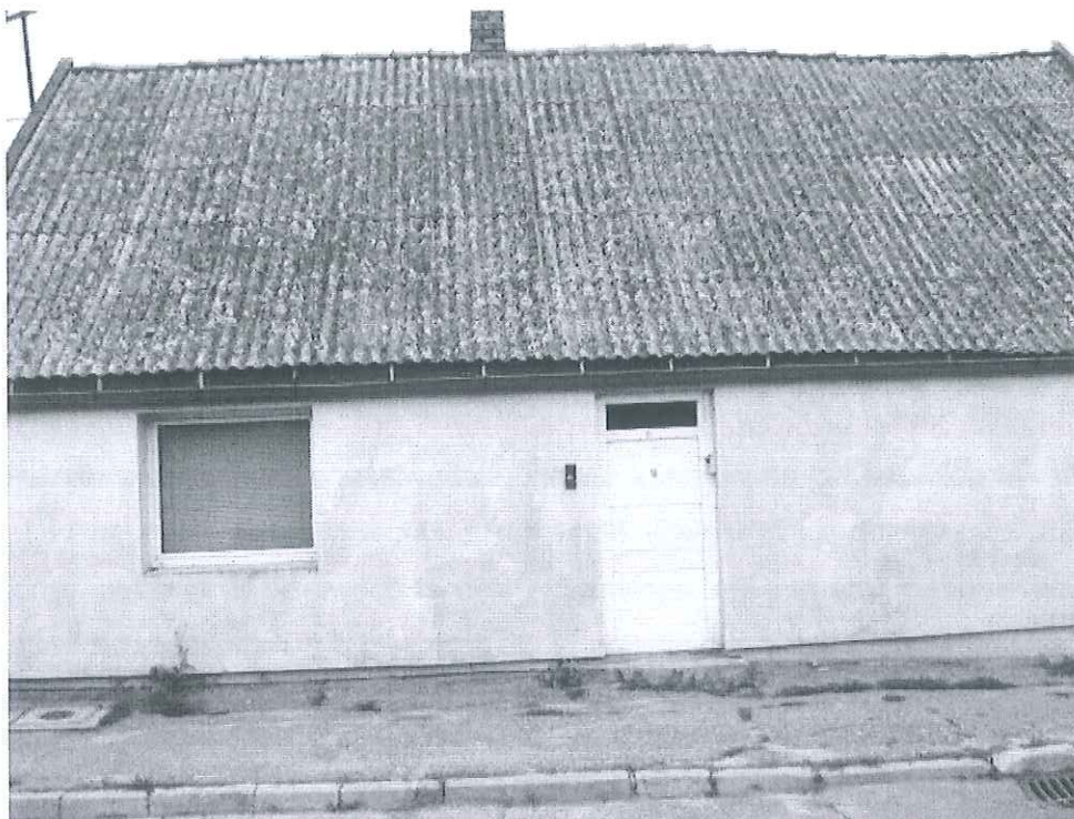
Rysunek 7 Pokrycie dachowe ocenione w II stopniu pilności.
