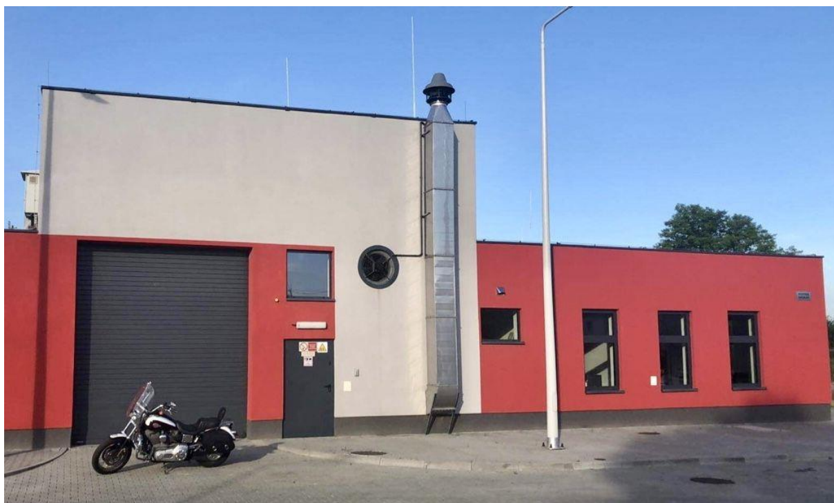
Rysunek 23. Budynek przepompowni ścieków zlokalizowanej przy ulicy Starojaworskiej 109A
