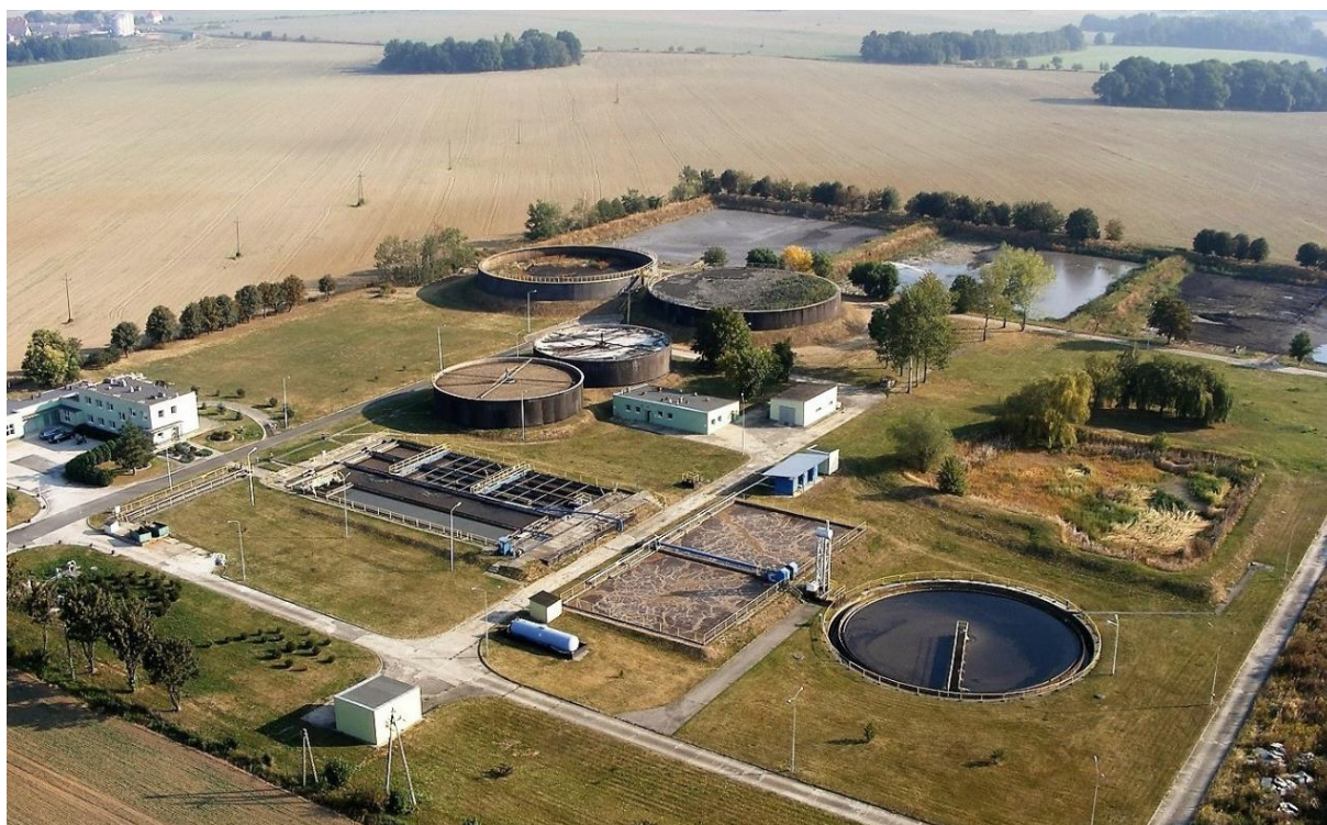
Rysunek 22. Oczyszczalnia ścieków w Małuszowie
